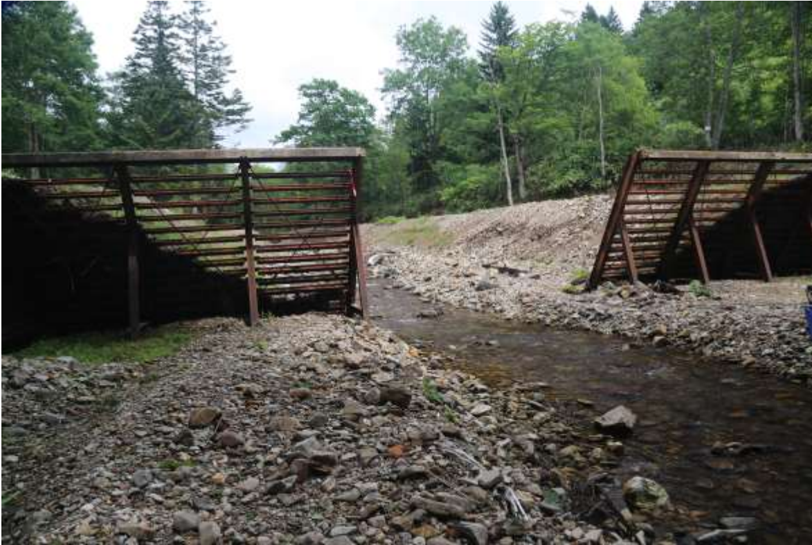
鋼製ダムのスリット化
