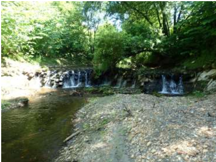
落差工下流部の護床ブロック下流端に1.20m程の落差
