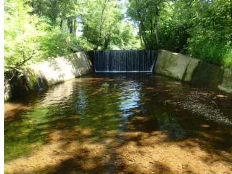
落差工下流部はウォータークッションがあり、洪水時にはサクラマスの遡上は多少あり
