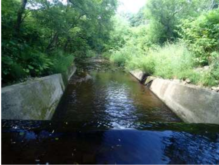
落差工下流部はウォータークッションがあり、洪水時にはサクラマスの遡上は多少あり
